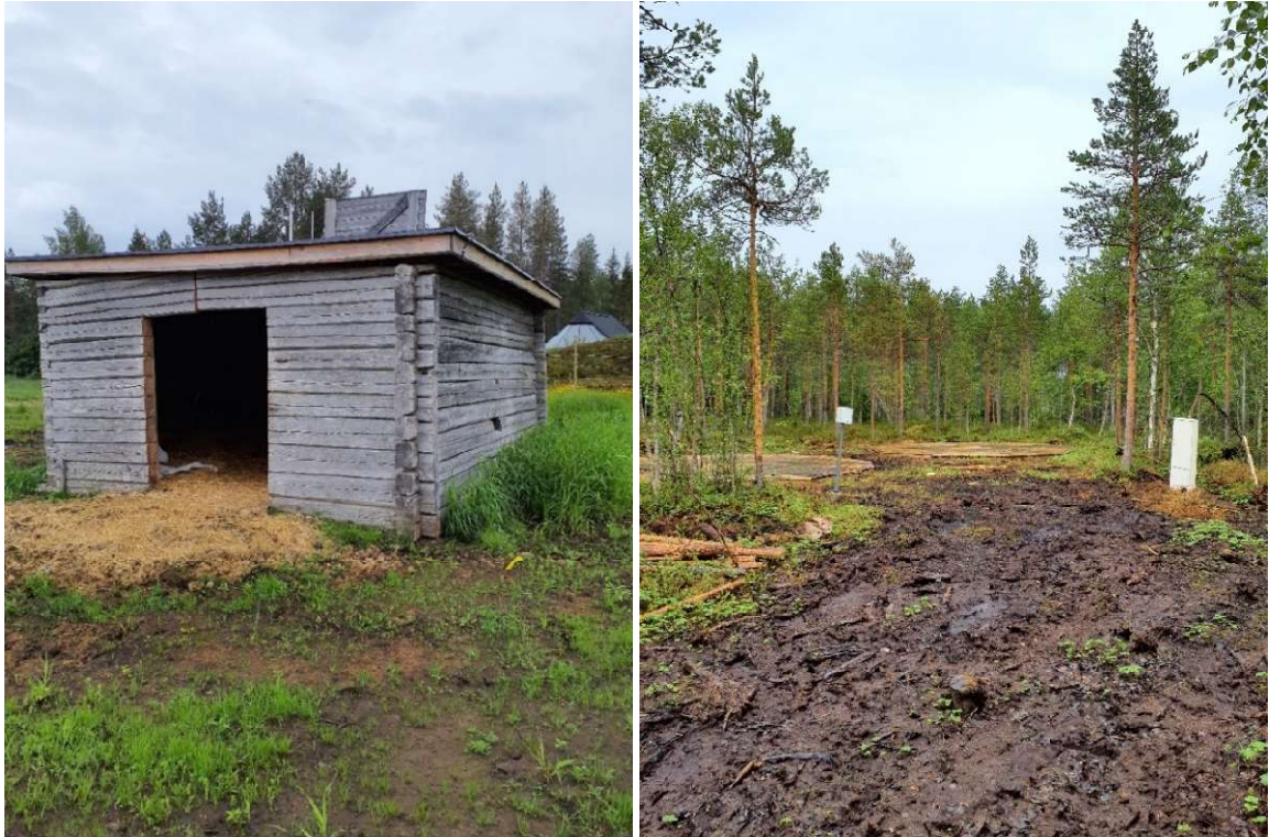
Kuva 11. Kausittaiseen eläintenpitoon käytettävä hirsirakennus Apukka 2:n pohjoisosassa, Apukka Resortin pihapiirin tuntumassa (vas.). Noin 75 metriä Olkkajärven rannasta sijaitsee kaksi vasta rakennettua puurakenteista teltan/kodan pohjaa, sähkökeskus ja sähkötolppa (oik.) alueen eteläisessä osassa.
