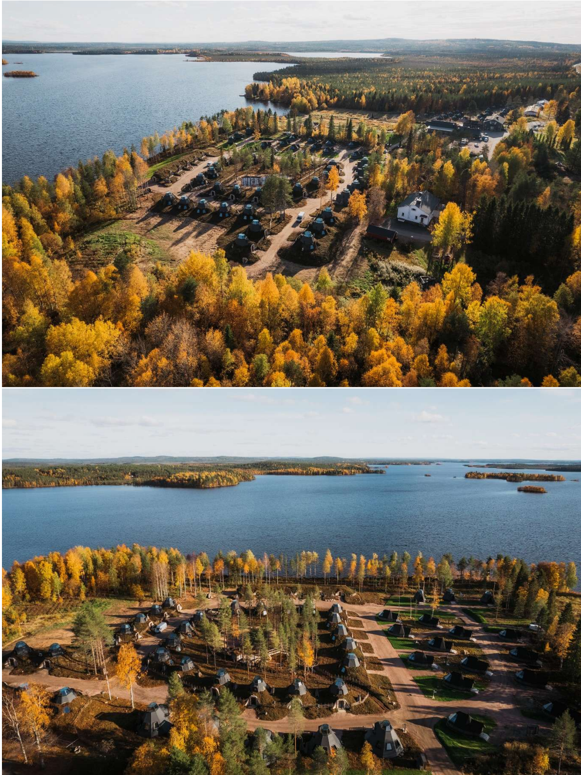
Kuva 16. Apukka Resortin rakennuksia VT 4 suunnalta.
